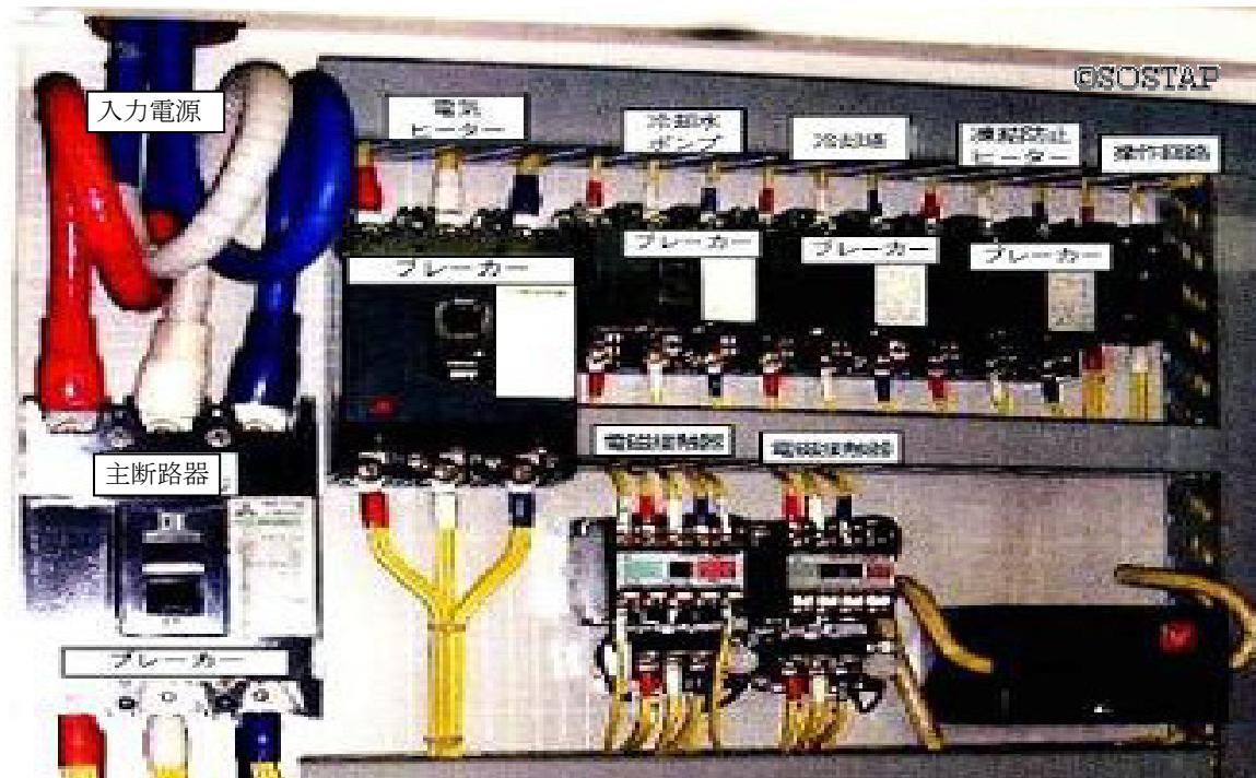
図 1-9 配電盤の例 (入力電源は主断路器で受電されてブレーカ：断路器を介して各ユーティリティに分配される)
