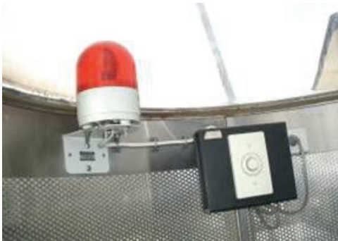
図5. - 6(k) オペレータ待機位置にあるブザー及び回転灯
