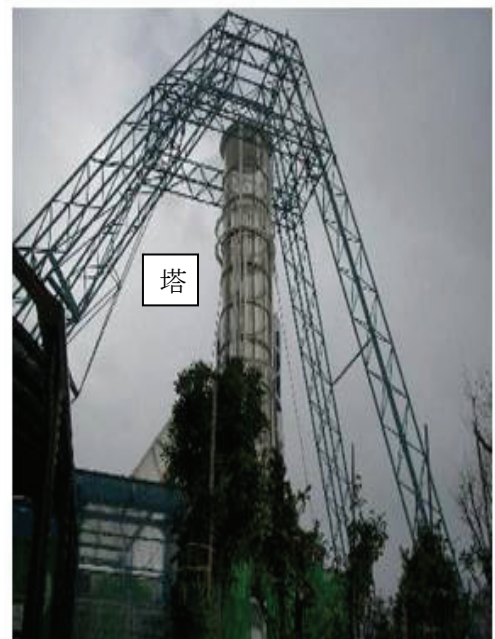
(b) 設備の全景
