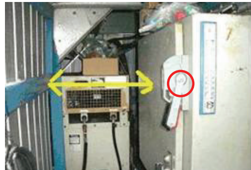
図5. - 6(m) 制御盤室（バックスペース410mm Min.）赤丸はロックアウトのための施錠用の開口部
