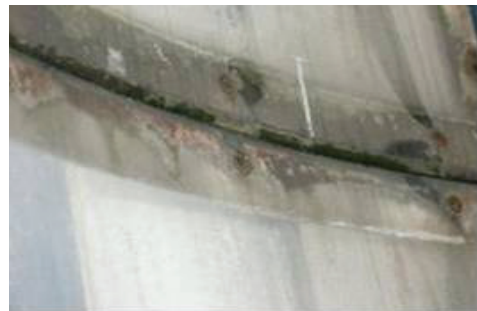
図5. - 6(h) 塔内部の様様（フレームに錆びあり。ポリカーボネート板にヒビあり）
