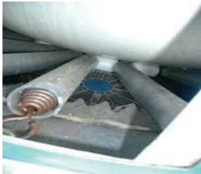
図5. - 6(e) 塔下部緩衝スプリング
