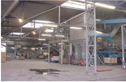
図 2.1.2-5 処理設備の全体像
