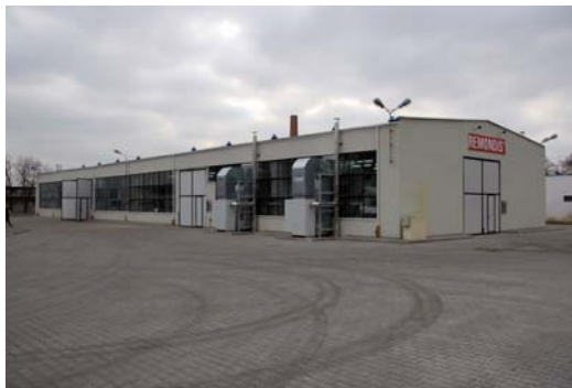
図 2.1.2-19 解体センター全景
