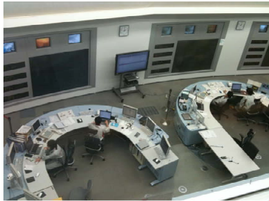
図 2.1.1.2 運転センター（中央操作室）
