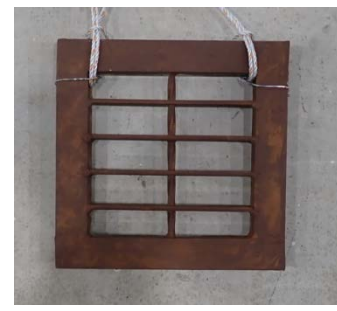
グレーチング (錆あり)
