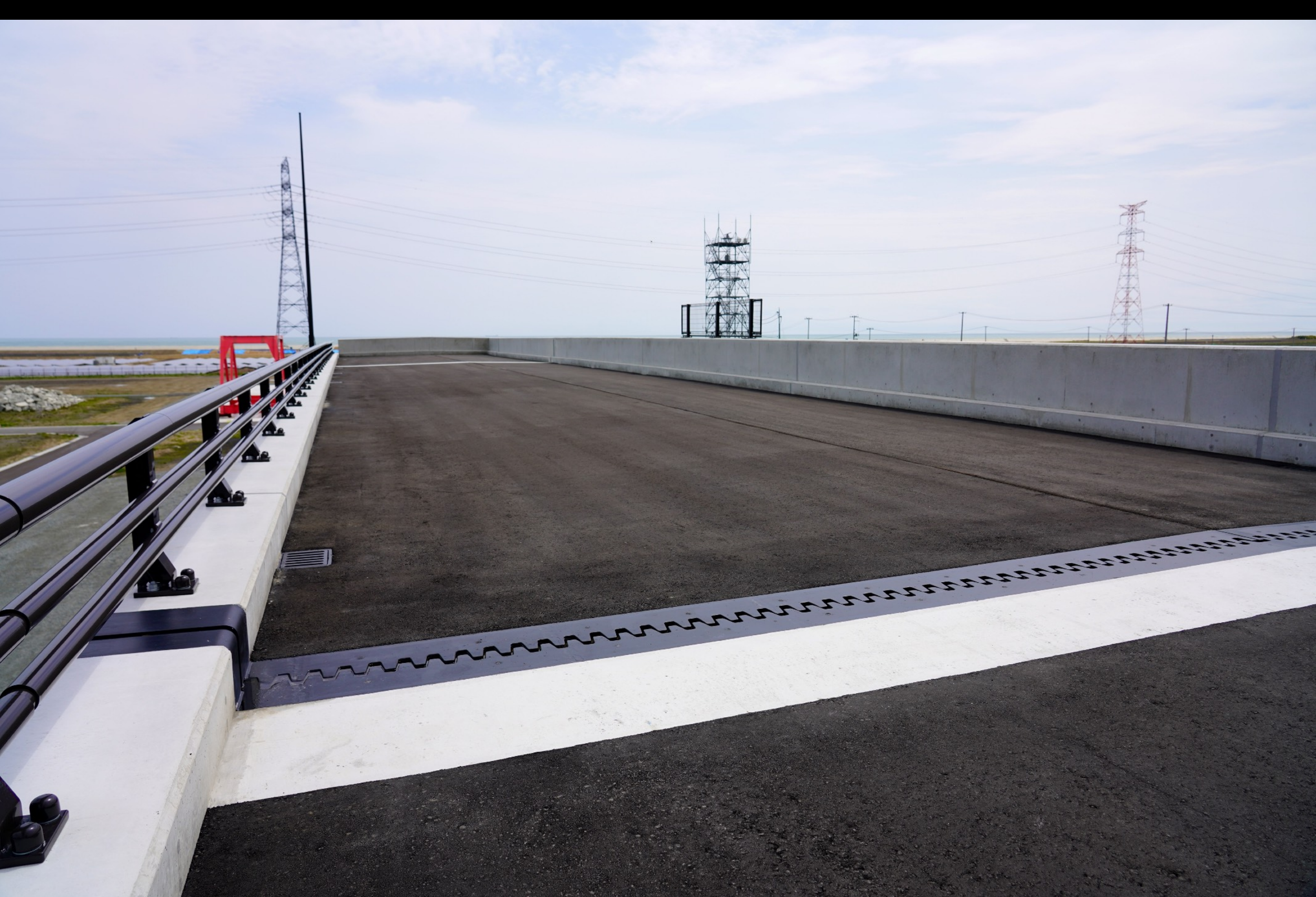
福島RTF試験用橋梁舗装面
