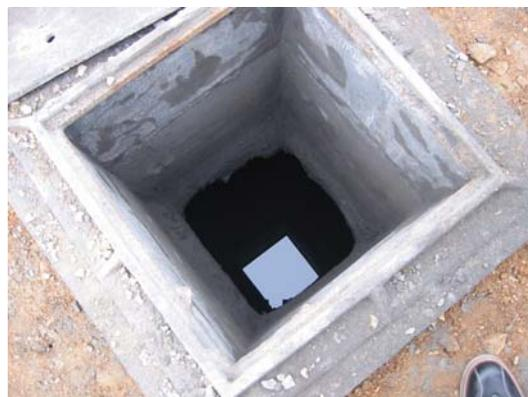
図 3.3.2-8 油水分離槽(最終槽)(2002年)
