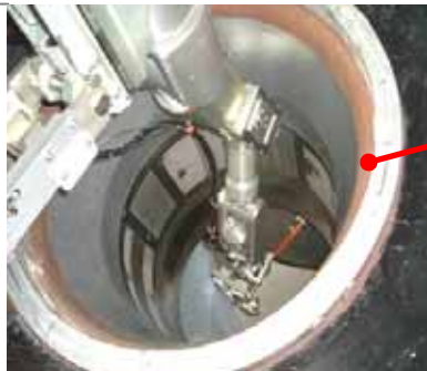
原子炉容器管台 溶接補修システム
