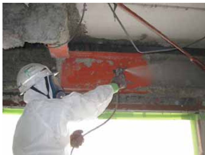
写真 3.1.9-1 アスベスト除去作業
