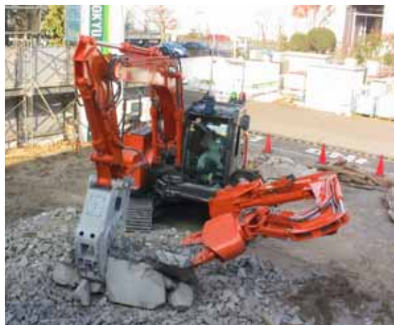
写真 3.1.9-3 双腕型解体機
