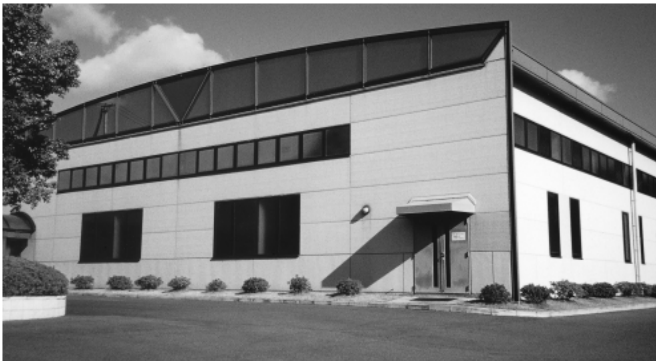
ミツ精機 本社工場
