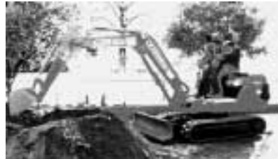
バックホウによる掘削作業
