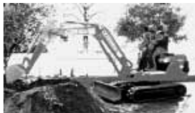
バックホウによる掘削作業
